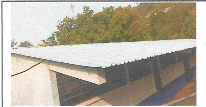
Foto 1: Cambio de duralita por lamina troquelada finalizado
