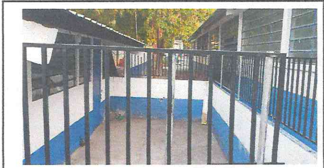
Foto 2: sustitución de maya por baranda de metal finalizada
