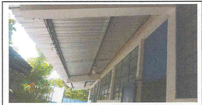
Foto 6: anclaje de costaneras galvanizadas sobre jois finalizado
