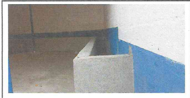
Foto 3: cuneta de concreto finalizada
